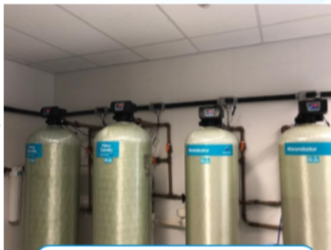
Abrandador: dureza (ex. Ca e Mg) Carvão: cloro, odor, sabor.. Ultrafiltração: pequenas partículas de carvão
